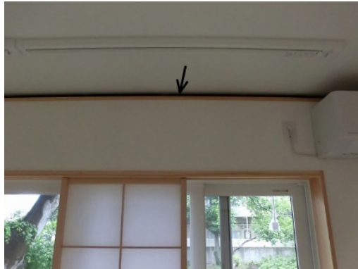
写真 洗浄用ホースを差し込むためのスリット
