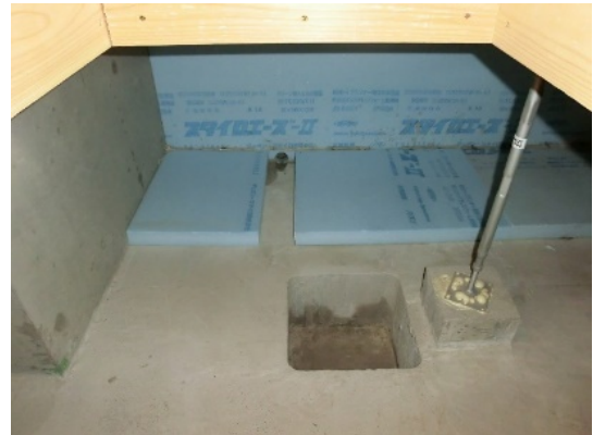
写真 床下排水孔と釜場
