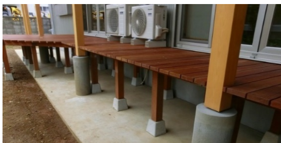
写真 基礎高 GL+700mm
