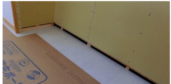
写真 巾木裏の排水用スリット
